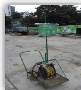
使用废弃铁枝制作固定或降尘装置
